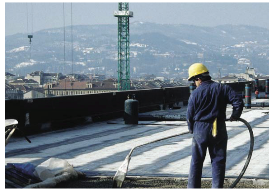
روش کف سبک به وسیله دوغاب ریزی
