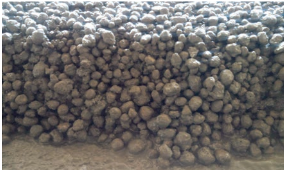
مقطع کفسازی اجرا شده با روش دوغاب ریزی
