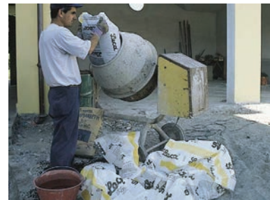
کفسازی با روش بتن سبکدانه
