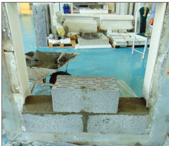
شکل ۱. اجرای دیوار با بلوک های سیمانی و استفاده از ملات ماسه و سیمان در درز بلوک ها
