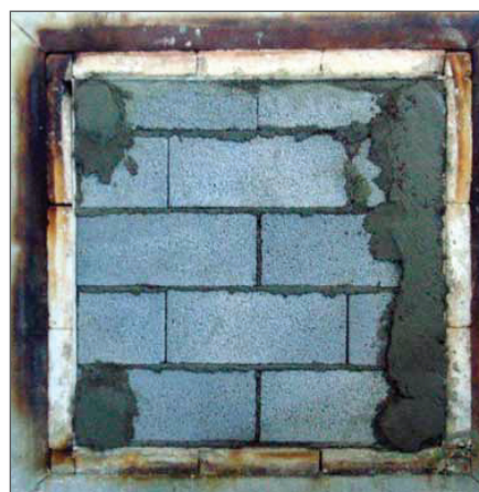
شکل ۳- اجرای ملات ماسه و سیمان به ضخامت ۱ سانتی متر بر روی دیوار
