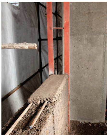
قرار دادن میلگرد مهاری در رگ ملات
