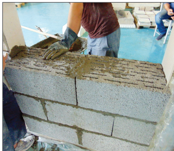
شکل ۱. اجرای دیوار با بلوک های سیمانی و استفاده از ملات ماسه و سیمان در درز بلوک ها
