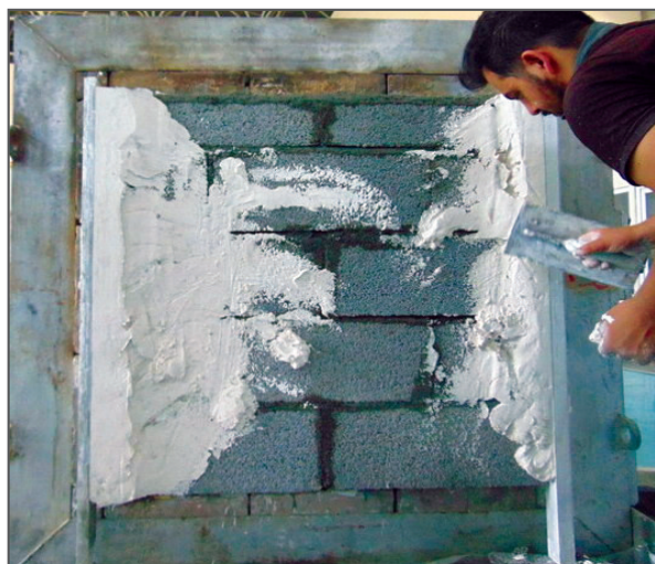
شکل ۳. اجرای اندود گچ به ضخامت ۳ سانتی متر بر روی دیوار
