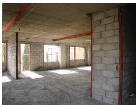
مهاری بندی کامل دیوارهای غیر باربر
