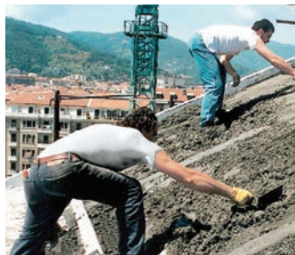
کفسازی با روش بتن سبکدانه
