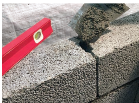
پر کردن درز قائم ملات ریزی در دیوار چینی
