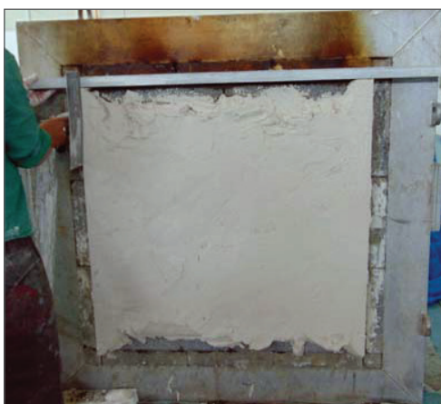
شکل ۴- اجرای اندود گچ به ضخامت ۳ سانتی متر بر روی دیوار
