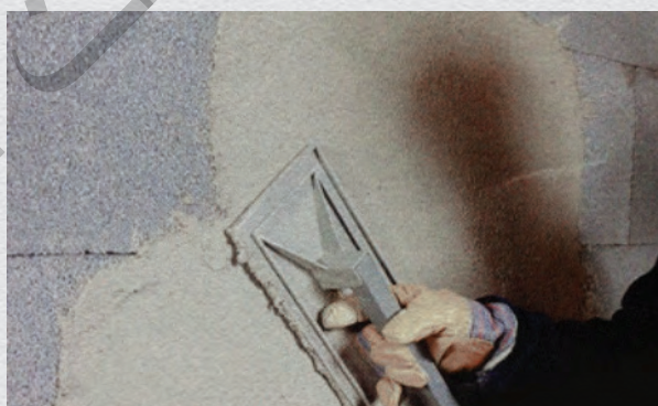
امکان اندود گچ کاری بدون نیاز به لایه گچ و خاک
