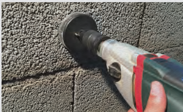
امکان برش کاری و نصب جعبه تقسیم برق
